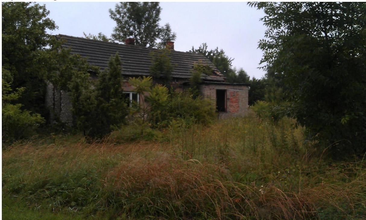
Zdjęcie 12. Opuszczona zabudowa
