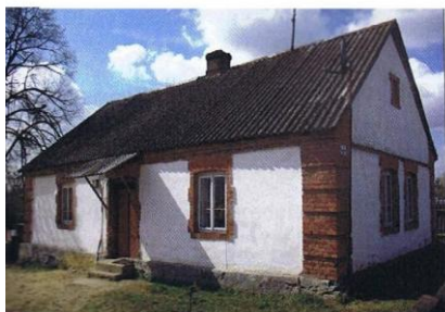
Fot. 5 Przykładowy obiekt z III stopniem pilności
