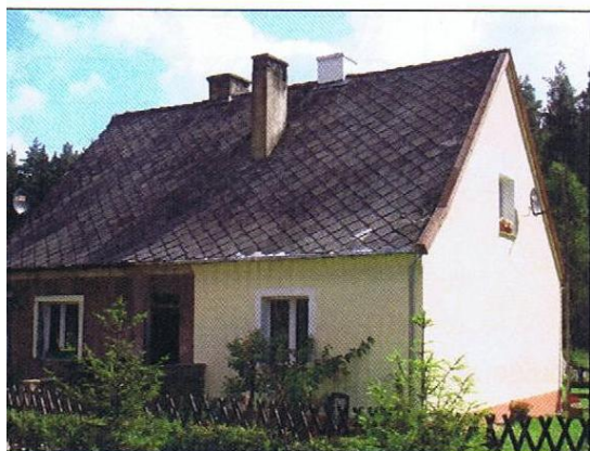
Fot. 2 Płyty azbestowo-cementowe płaskie
