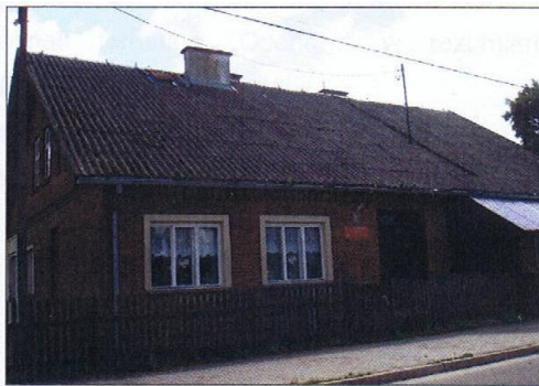
Fot. 4 Przykładowy obiekt z III stopniem pilności (obiekt użyteczności publicznej – szkoła)
